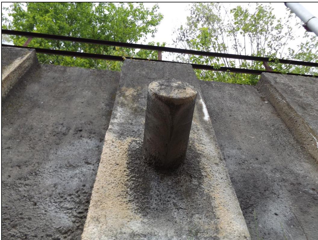
Obr. č. 5 – pohled na hlavu kotvy
